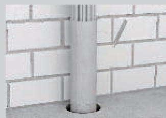
Pričvršćivanje zavoja žicom za navijanje.
