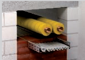
Provedene gorive cijevi s uzdužnom izolacijom.
