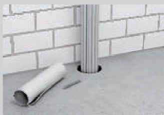
Priprema za zatvaranje kablskih prolaza.
