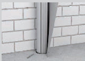
Instalacija protupožarne bandaže
